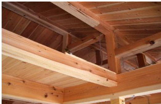
写真1 スギ構造材兼化粧材
