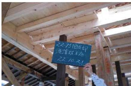
写真6 ヒノキ材による2階床梁（米原市）
