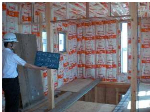
写真3 断熱材工法(長浜市)
