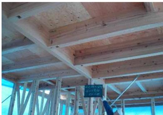
写真7 スギ横架材の使用状況（近江八幡市）
