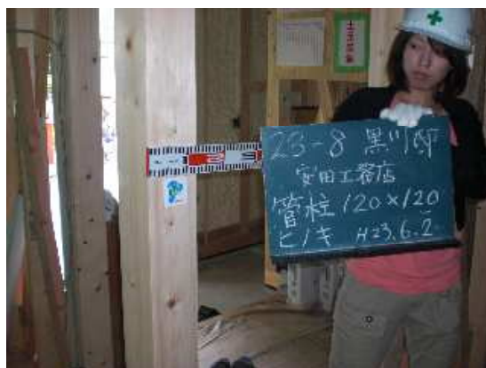
現地確認の状況
